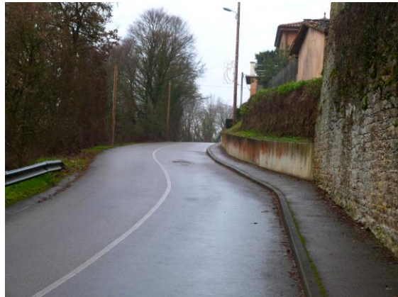
P21 : visibilité limitée côté nord par le bombage et la courbure de la route
