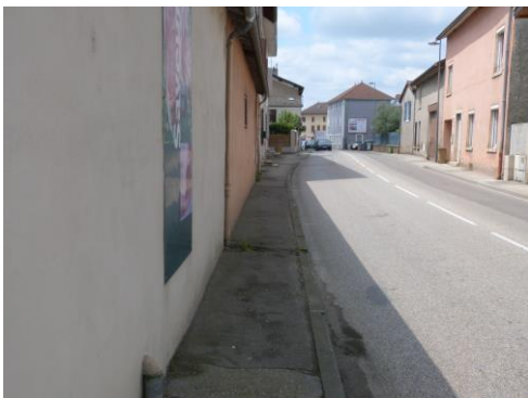
Trottoirs étroits avenue des Cèdres
