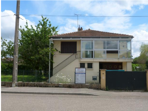
P6 : pavillon ancien (années 1950-1970) caractéristique avec la partie habitable à l'étage. Il fait l'objet d'un permis de construire pour son extension
