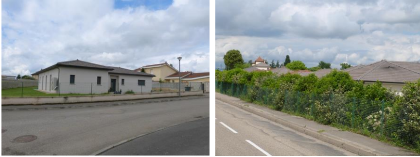
Nouvelles constructions avec des toitures de teinte ardoise
