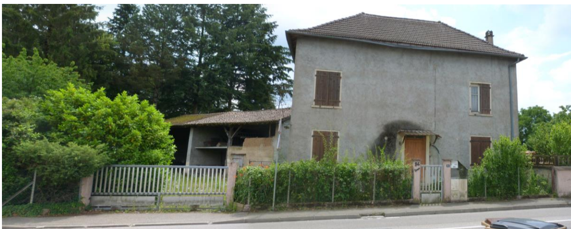
Photo P2 (ci-dessous) : enjeu de valorisation du potentiel de densification d'un front bâti ancien
